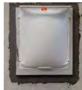
Auf Montagedämmplatte MEAFIX PRO montierter GFK-Lichtschacht MEAMULTINORM 3-in-1
